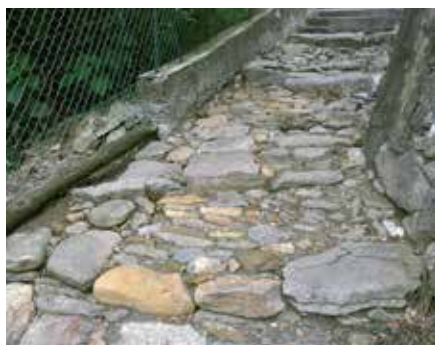
• Pavimentazione in selciato.
