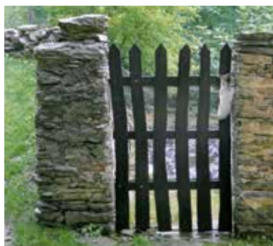
• Muretto in pietra di recinzione di orto.
