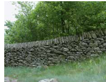
• Coronamento superiore in lastre posate a coltello.
