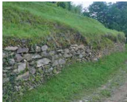
• Muro di sostegno di scarpata.
