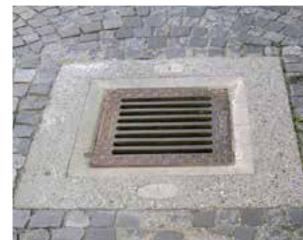
• Particolare caditoia in pietra.
