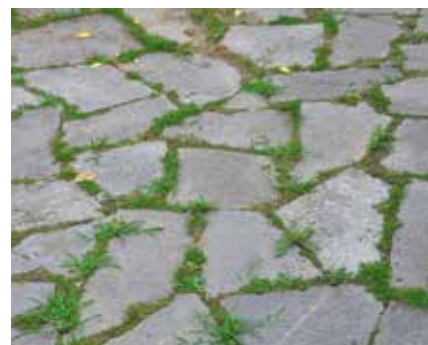
• Pavimentazione in lastricato con giunti inerbiti..
