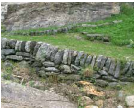
• Muro di contenimento presso un sentiero.
