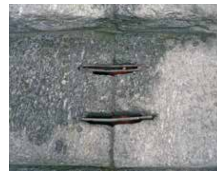
• Particolare caditoia in pietra.
