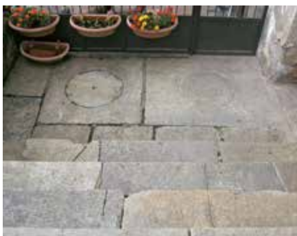
• Pavimentazione in selciato.
