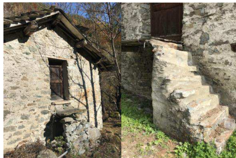
Figura 91: scala in pietra perpendicolare alla facciata con pianerottolo in legno a sbalzo, Val Soana
