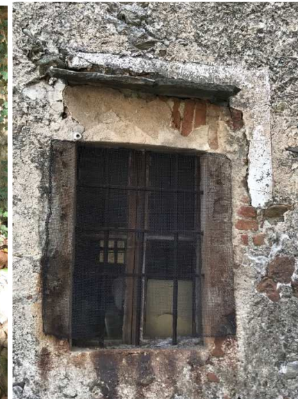
Figura 50: architrave in conci di mattoni
