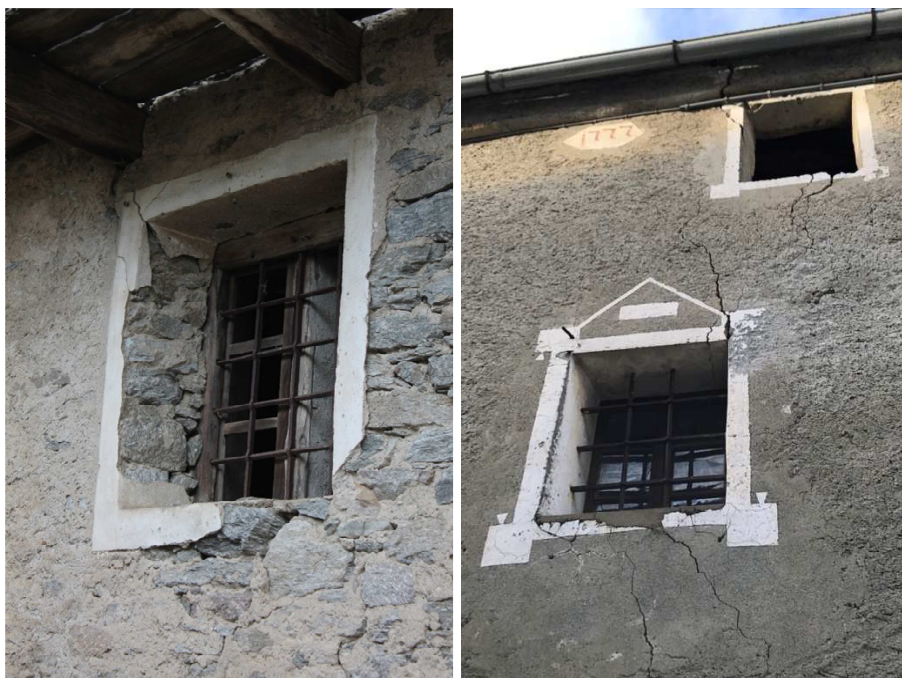
Figura 33: vano in muratura e cornice intonacata
