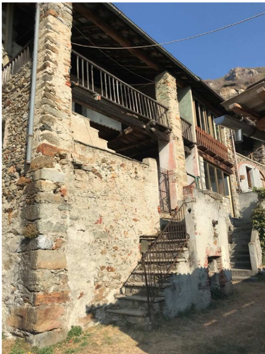
Figura 105 loggiato con piano terra chiuso da muratura
