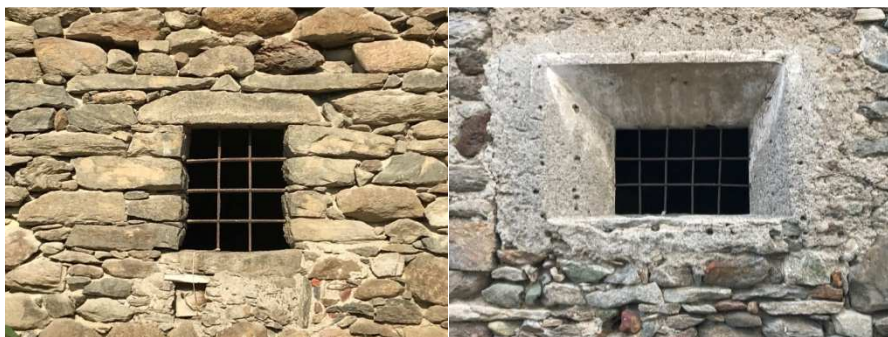
Figura 34: vano in muratura a vista e apertura strombata
