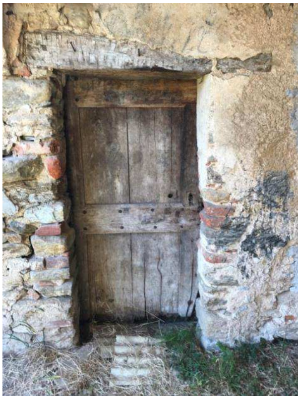
Figura 35: architrave in legno intonacato
