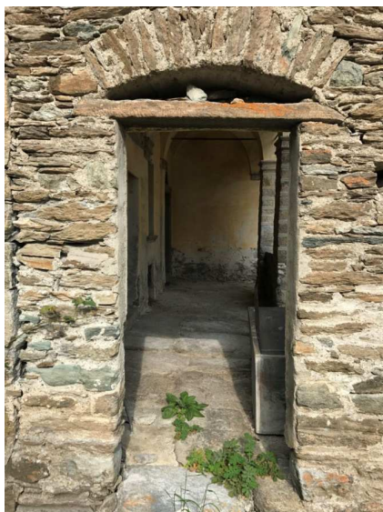
Figura 47: architrave e piattabanda in conci di pietra
