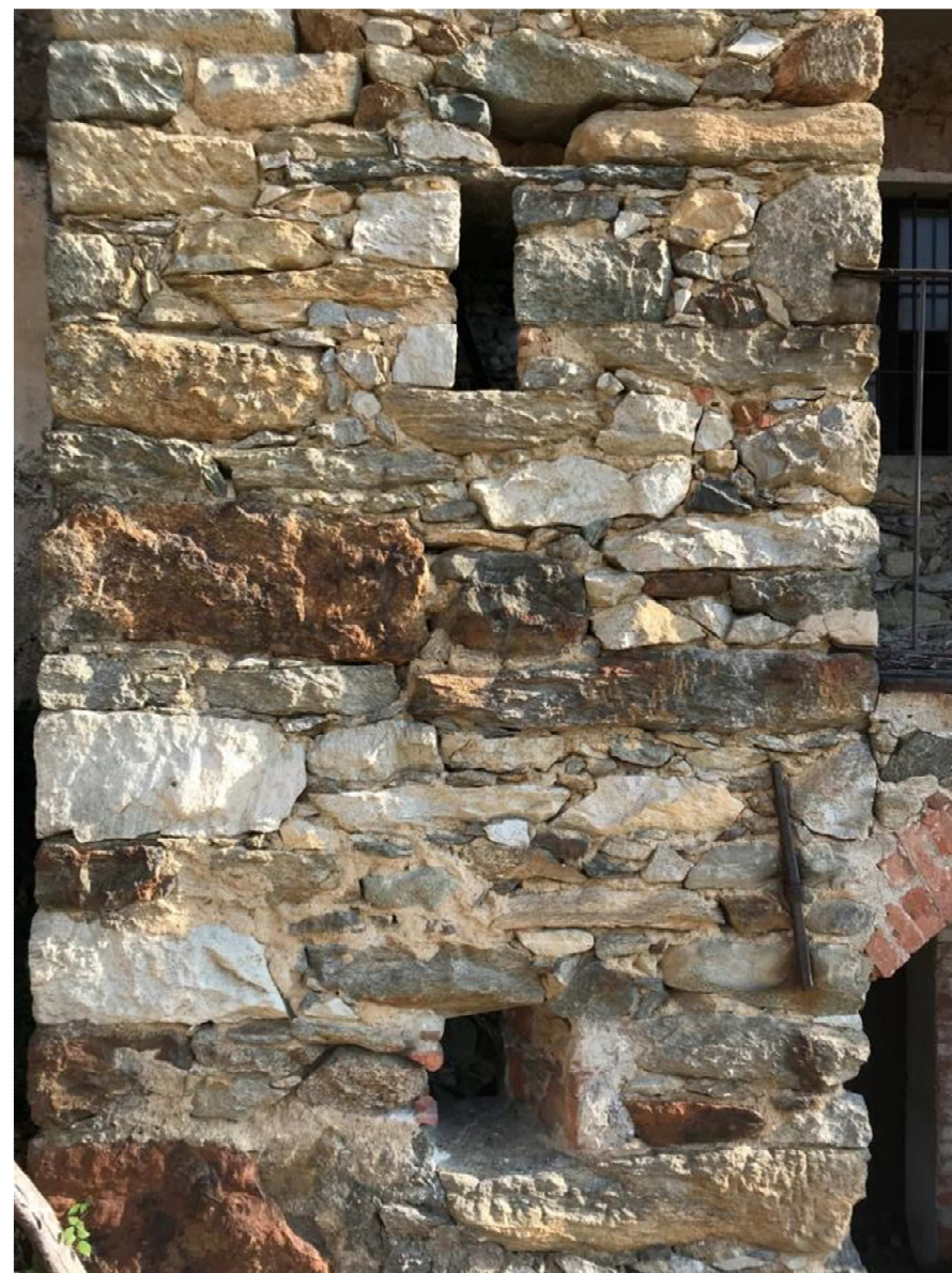
Figura 69: pietra a spacco, corsi irregolari, con scaglie in pietra e ammassamento angolare
