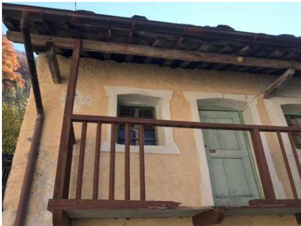
Figura 12: sporto laterale del tetto; Val Soana
