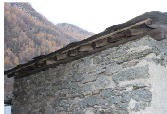
Figura 2: particolare della trave dormiente sul muro perimetrale
