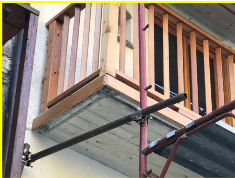
Figura 108 soletta in cls mascherata con profili lignei
