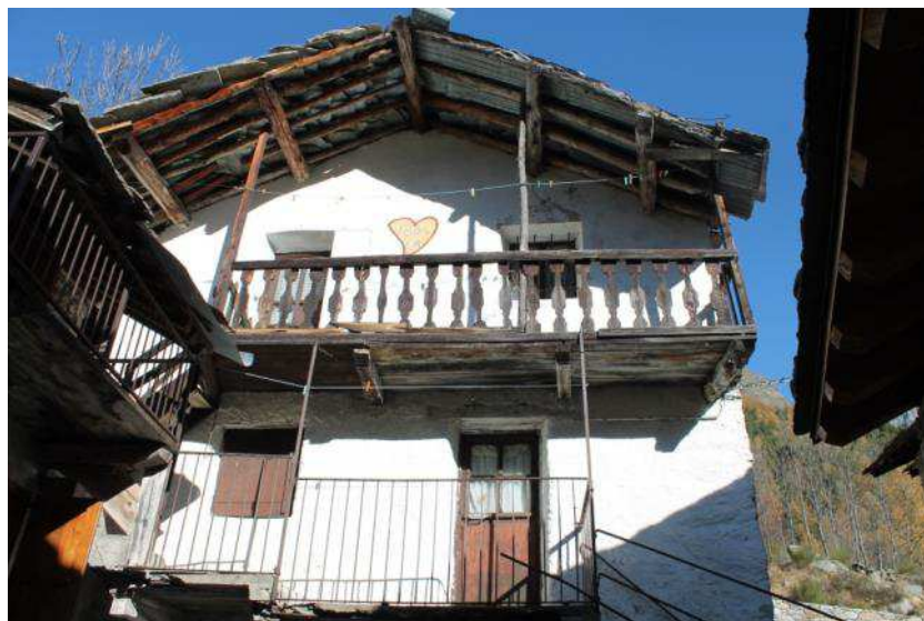
Figura 97: ballatoio con parapetto in tavole di legno sagomate
