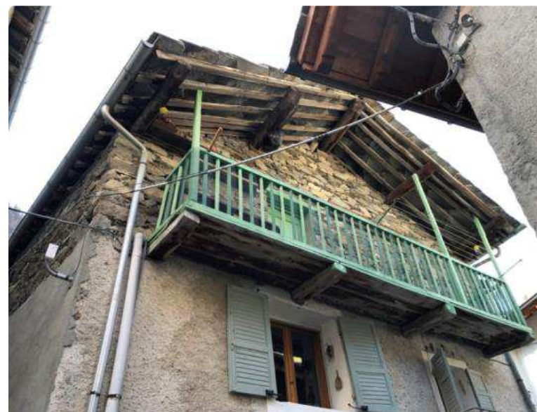
Figura 99: ballatoio all'ultimo piano con parapetto e montanti lignei colorati
