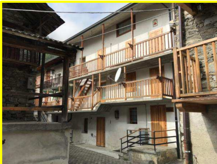
Figura 108 soletta in cls mascherata con profili lignei
