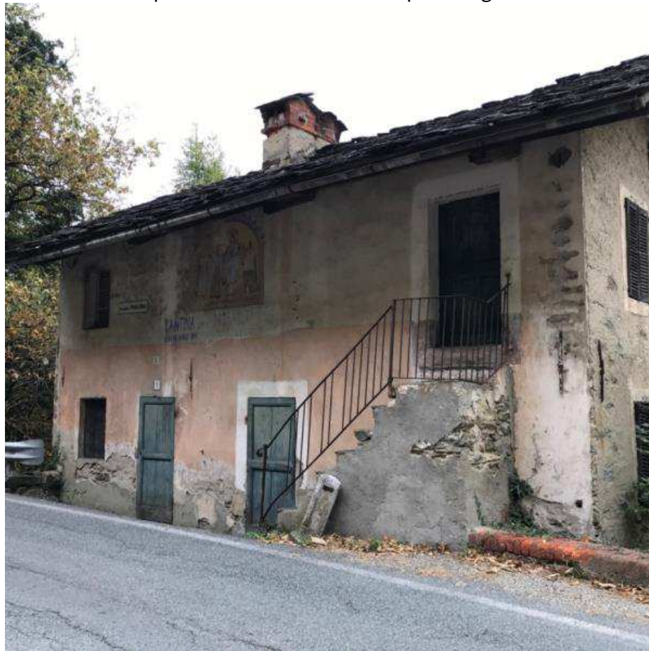
Figura 92: scala in pietra intonacata e ringhiera metallica
