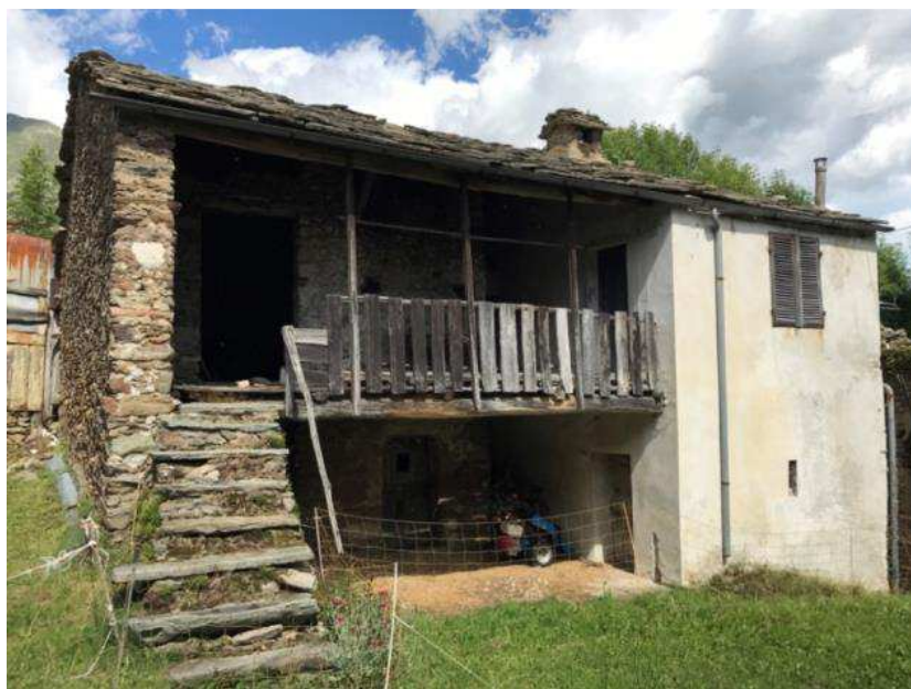
Figura 96: ballatoio con parapetto in tavole di legno rettangolari
