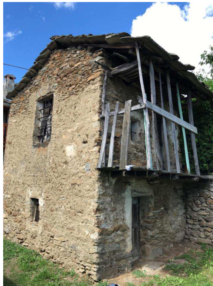
Figura 95: ballatoio con parapetto in listelli verticali
