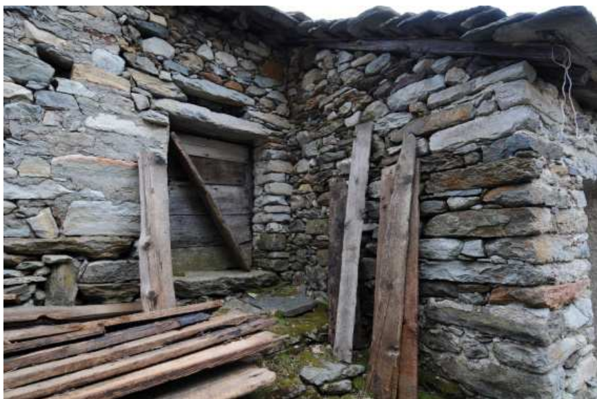
Figura 39: doppio architrave in pietra
