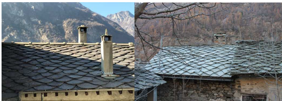
Figura 5: losa a goccia e losa quadrata
