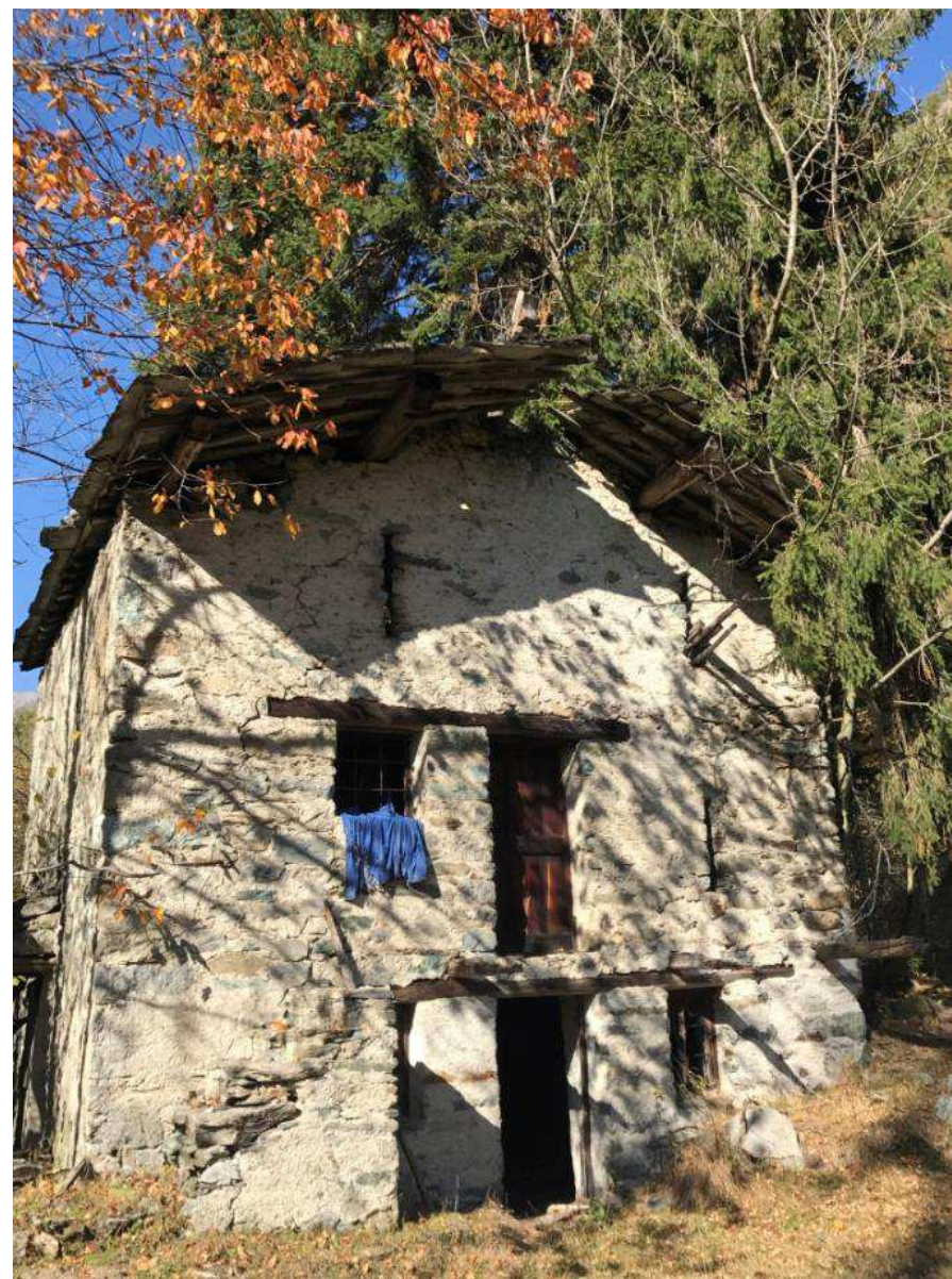
Figura 42: architrave ligneo passante sopra porta e finestre
