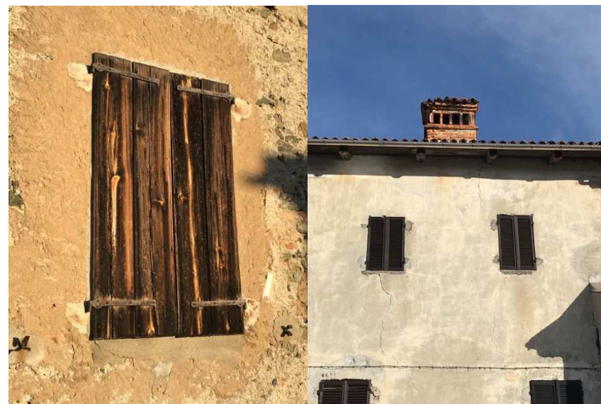
Figura 56: ante cieche a filo muro
