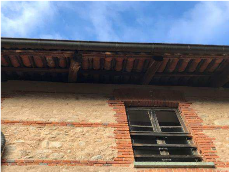
Figura 89: muratura in pietrame con ricorsi in laterizio
