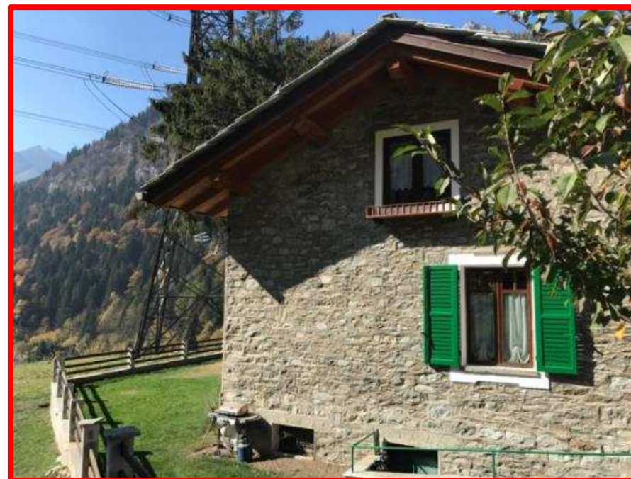
Figura 63 inserimento di ante a persiana colorate su muratura in pietra
