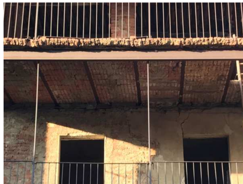
Figura 106 loggiati con solai realizzati con voltini in mattoni e putrelle e montanti in metallo
