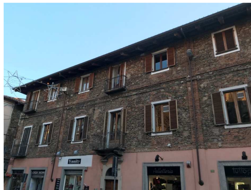
Figura 83: Castellamonte. Muratura in pietra e laterizio
