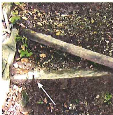
Ferro di armatura sporgente
